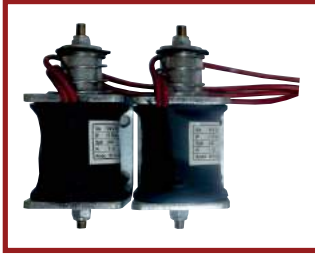
36 kV 24 V (DC) Yük Ayırıcı
